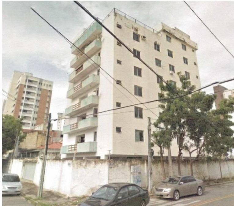
Figura 5 - Edifício Andréa antes do desabamento
