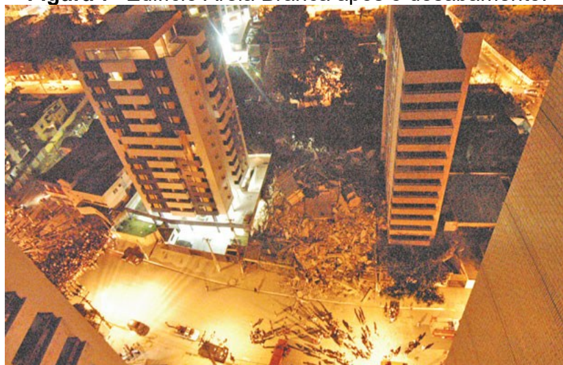
Figura 7- Edifício Areia Branca após o desabamento.
