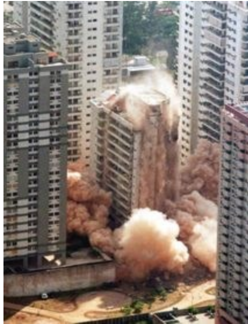
Figura 4- Implosão do Edifício Pallace II após os dois desmoronamentos.
