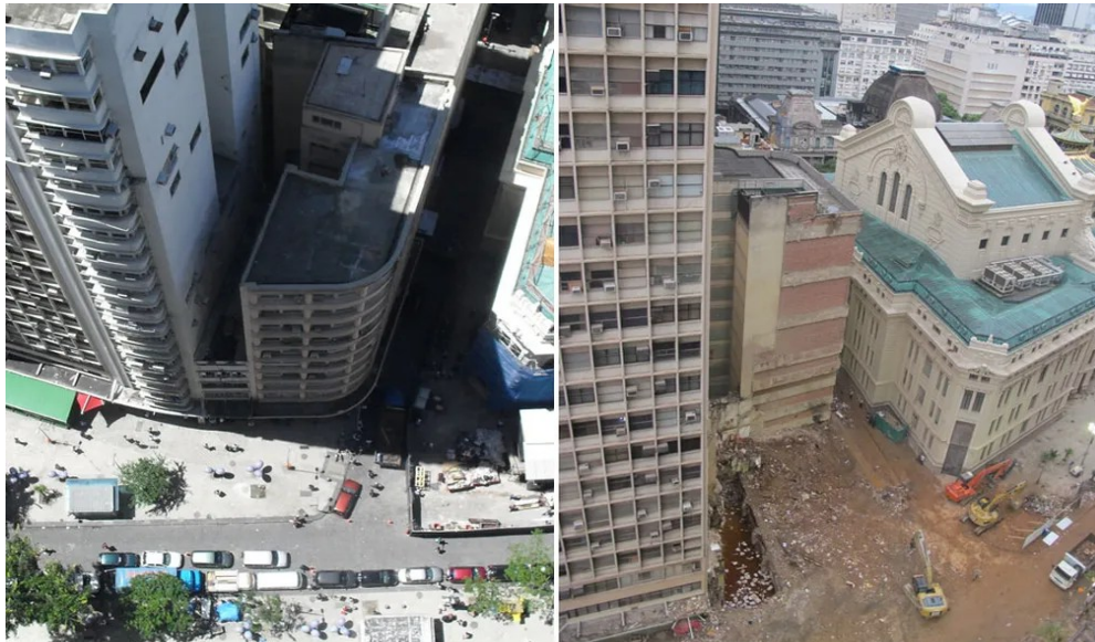
Figura 6- Edifício Liberdade antes do desabamento em 2009 (esq.) e após do desmoronamento em 2016
