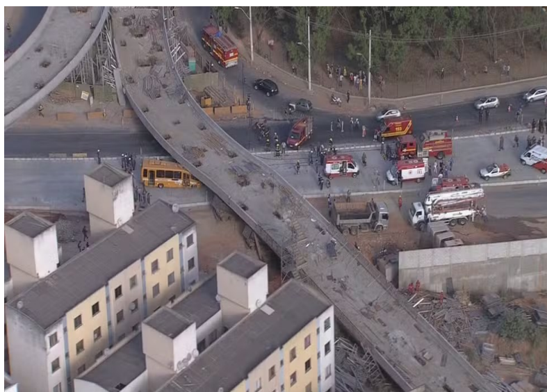
Figura 1- Visão aérea do Viaduto Batalha dos Guararapes, em Belo Horizonte, no dia da queda.
