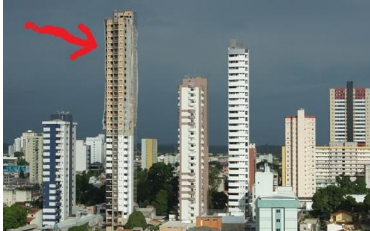
Figura 2- Vista do Edifício Real Class, em Belém antes do desabamento
